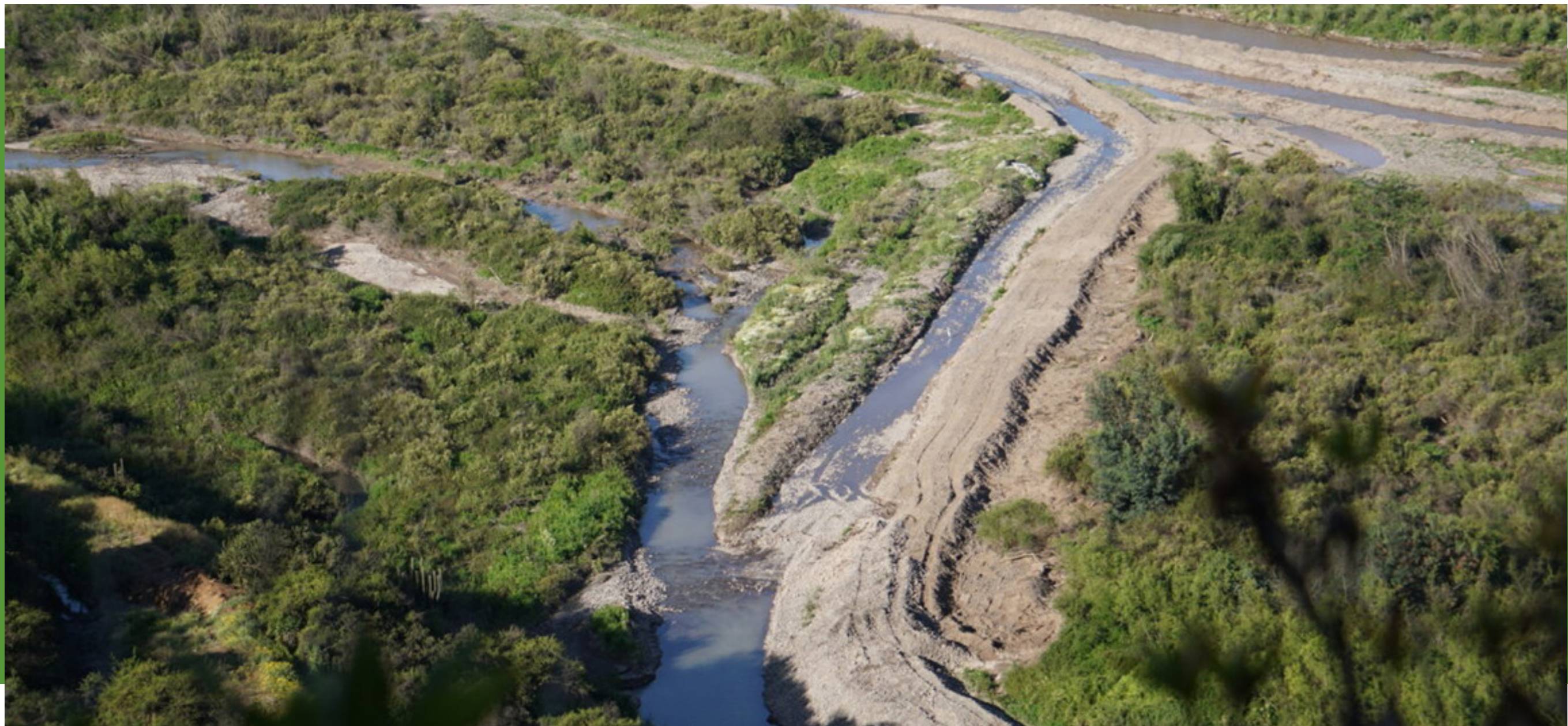
FOTO DE LA TERCERA SECCIÓN DEL RÍO ACONCAGUA, EN LAS INMEDIACIONES DE LAS BOCATOMAS DE CANALES.
